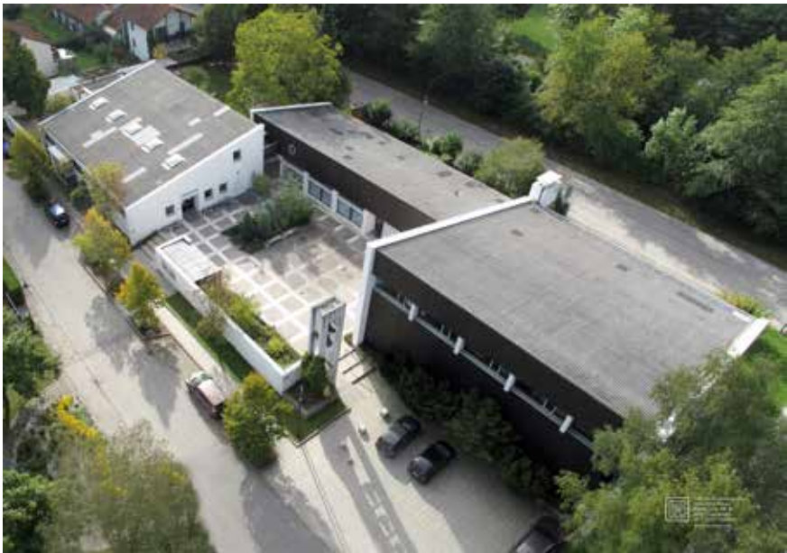
Blick auf das Kirchenzentrum
