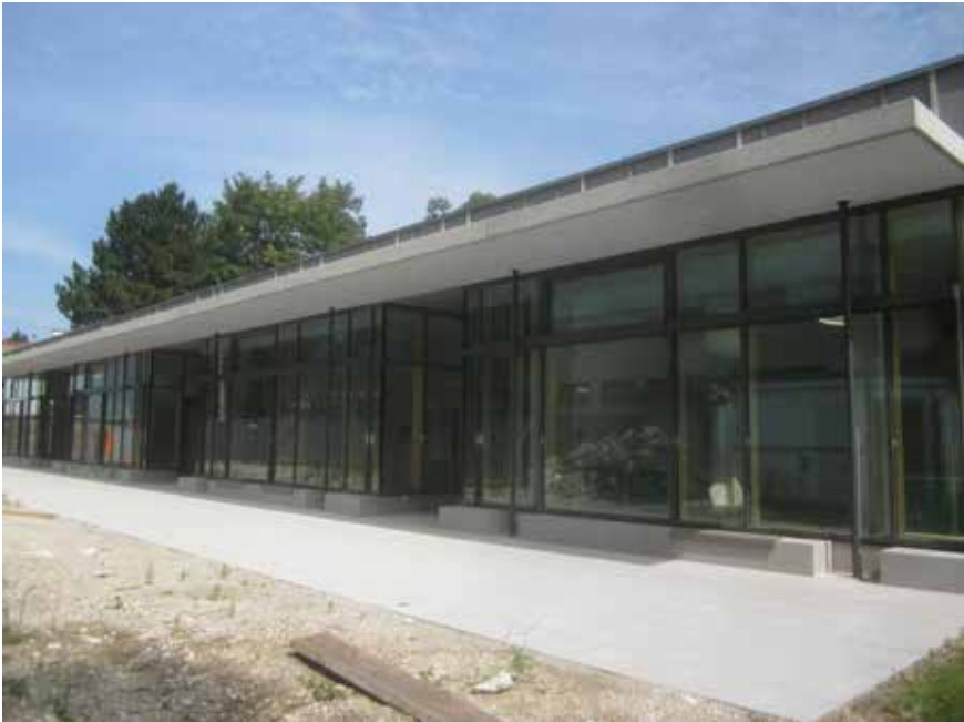
Blick von Süden auf die vier Gruppenräume 8.7.2018
