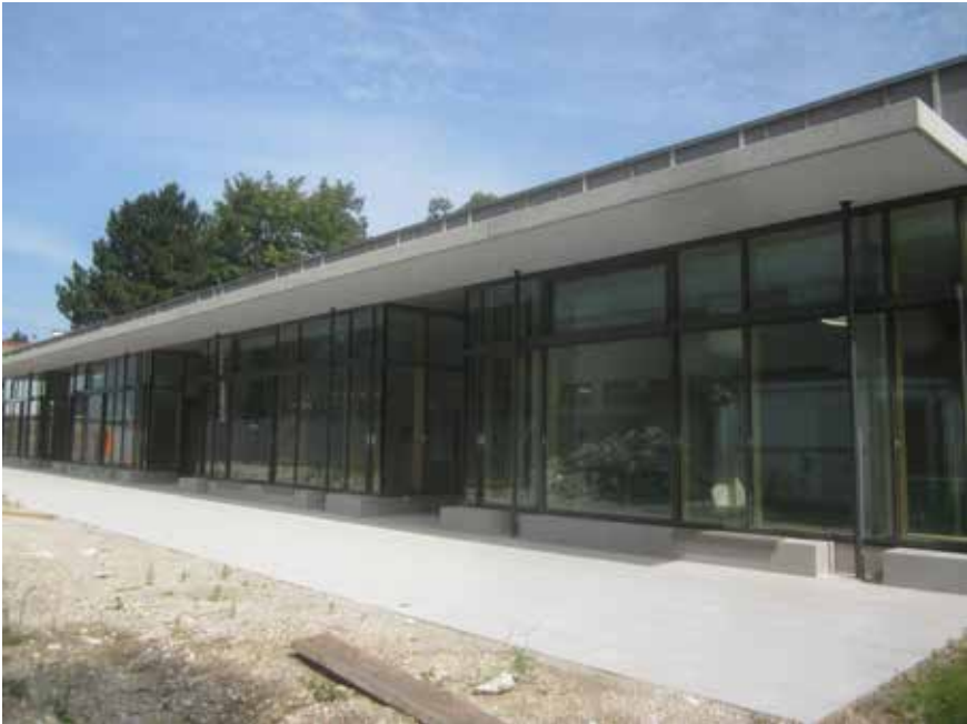
Blick von Süden auf die vier Gruppenräume 8.7.2018
